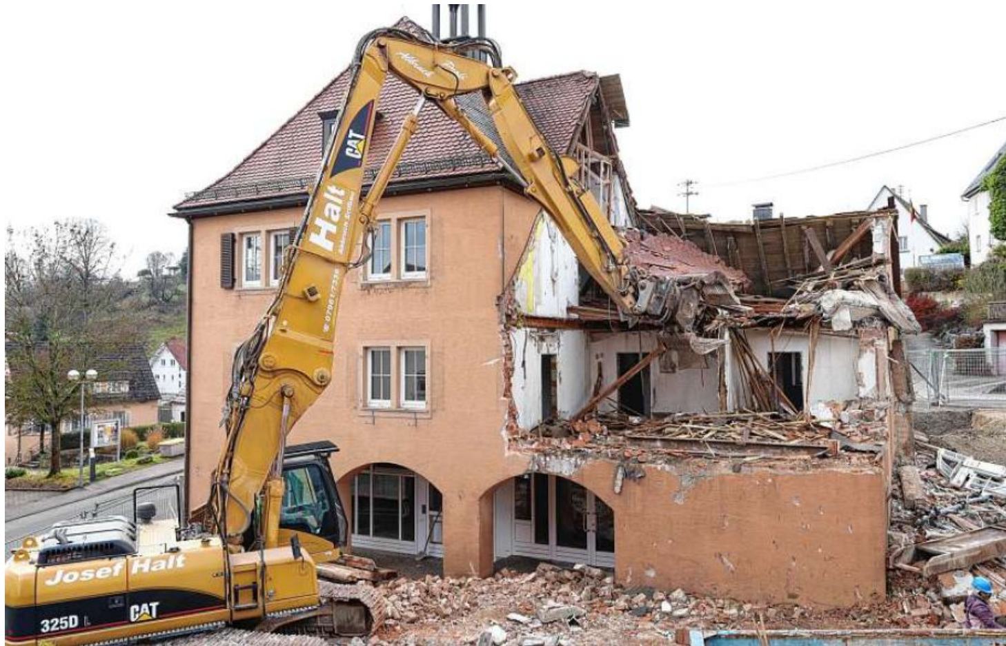
Die Abrissarbeiten am alten Jagstzeller Rathaus sind in vollem Gange.
