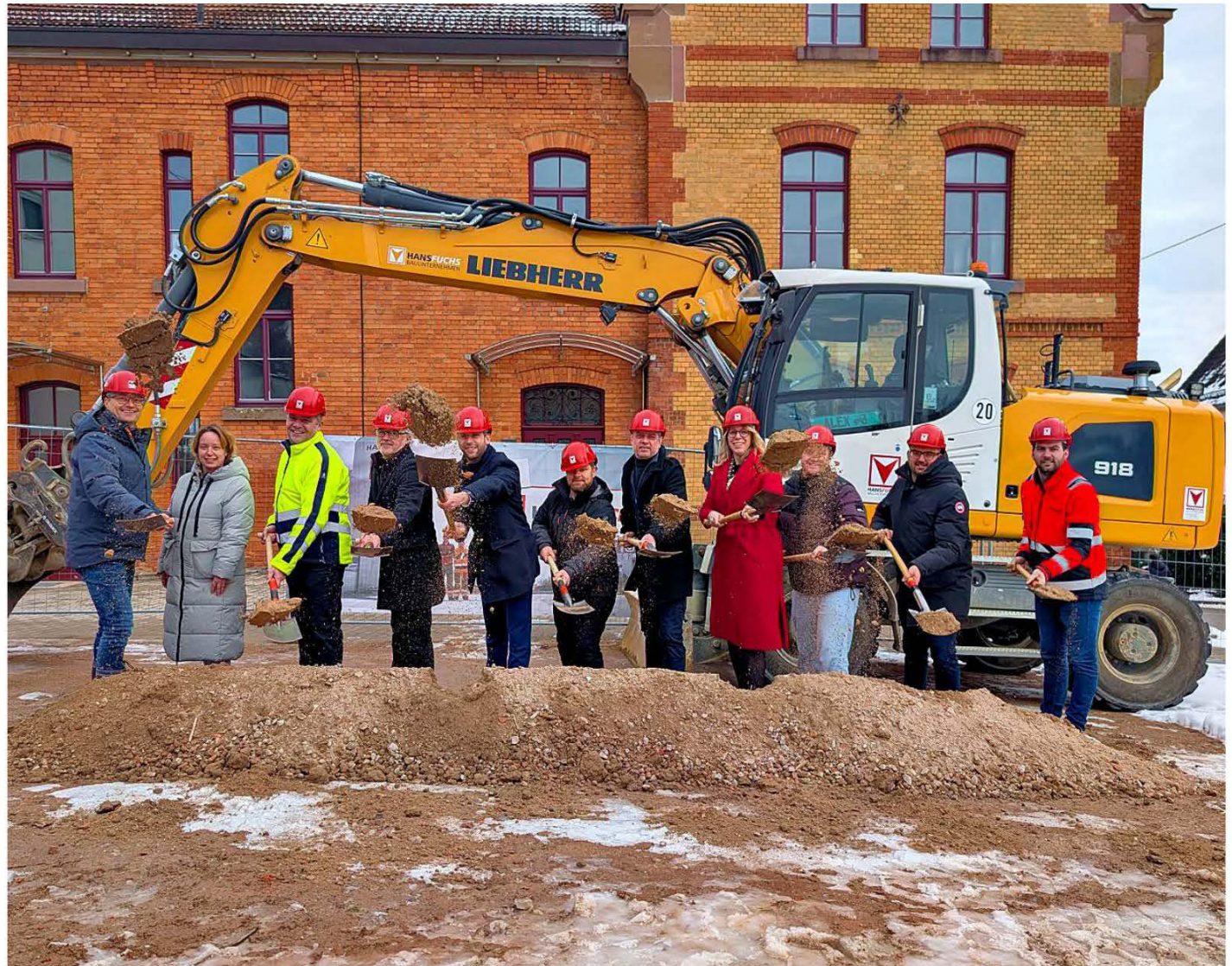
Der Spatenstich für das neue Jagstzeller Rathaus ist am Mittwochmorgen erfolgt. Nun kann es offiziell losgehen.
